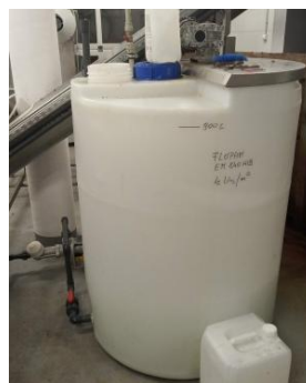
Rys.3.3.11 Przykładowe rozwiązanie prasy oraz stacji polielektrolitu.
