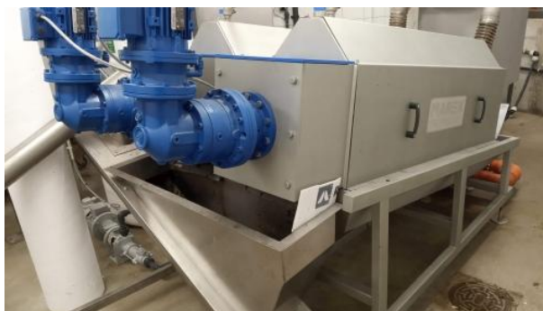
Rys.3.3.11 Przykładowe rozwiązanie prasy oraz stacji polielektrolitu.
